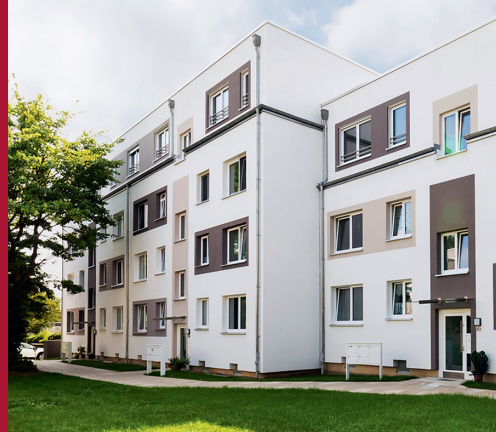
Gebäude nach Strategieumsetzung
