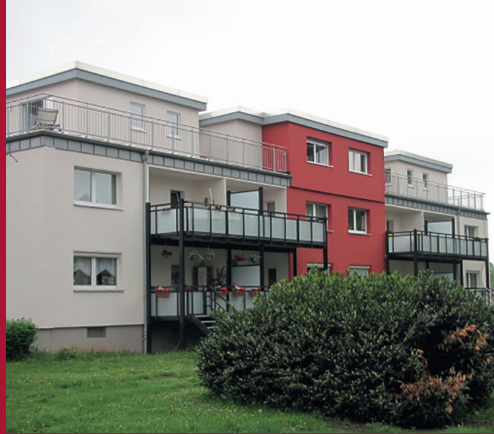
Gebäude nach Strategieumsetzung
